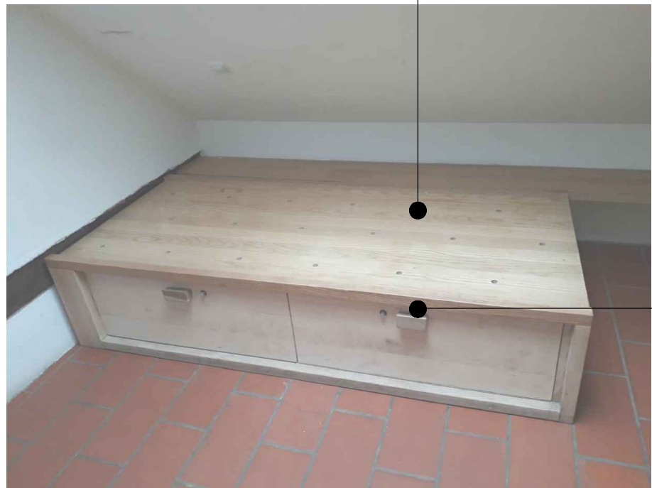
2. 28 x vgraditi ključavnico za osebno kontrolo odpiranja npr. SALTO XS4 Locker lock kompadabilno z sistemom, istega tipa ki bo služil kontroli odpiranja (v beli barvi)
