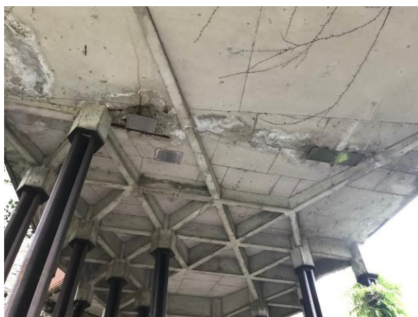
Slike 3, 4, 5 in 6: Razpoke na prekladni konstrukciji z izrazitimi sledovi pronicanja vode iz zgornje strani prekladne konstrukcije
