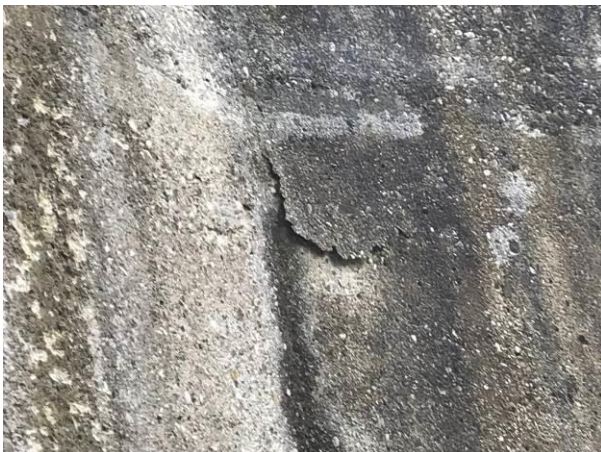
Sliki 16 in 17: Odstopanje zaščitne plasti betona nad korodirano armaturo in zmrzlinsko poškodovani spodnji deli betonskih stebrov
