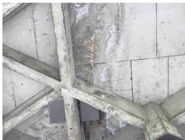
Slike 3, 4, 5 in 6: Razpoke na prekladni konstrukciji z izrazitimi sledovi pronicanja vode iz zgornje strani prekladne konstrukcije
