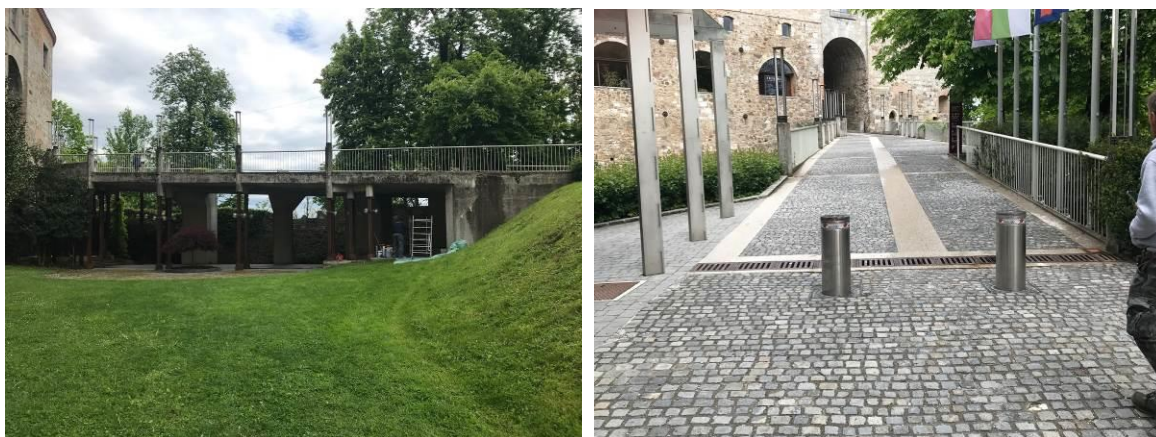
Sliki 1 in 2 : Pogled na most
