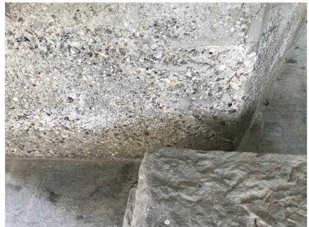
Sliki 16 in 17: Odstopanje zaščitne plasti betona nad korodirano armaturo in zmrzlinsko poškodovani spodnji deli betonskih stebrov
