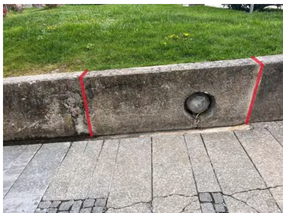
Izvedba kitane rege na izpostavljenem betonskem zidu med območjem D in zelenico
