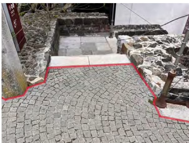
Območje D - odstranitev tlaka do prve kamnite stopnice
