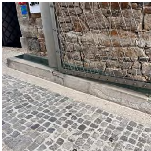
Močno razpokana betonska podlaga za vhodna vrata
