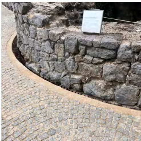
Betonski rob s slojem sige na kalnčini
