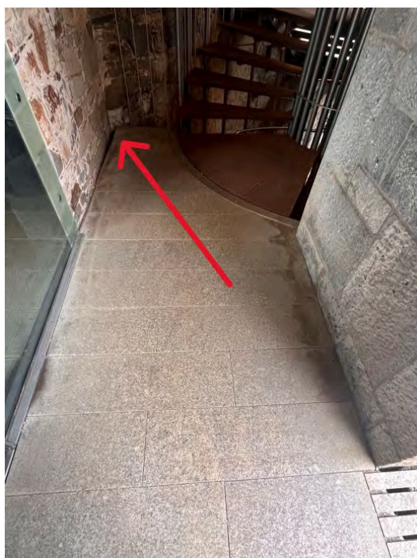
Območje C pri prostoru grajskega orožja s pogledom proti zavitim stopnicam - s puščico označen kovinski profil, ki ga je potrebno zamenjati z novim
