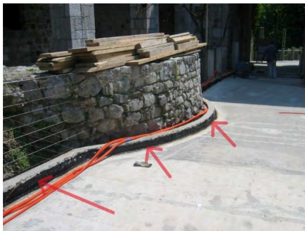
Tesnilno maso tipa Bituthene Liquid Membrane na betonu – fotografija iz sanacije leta 2006
