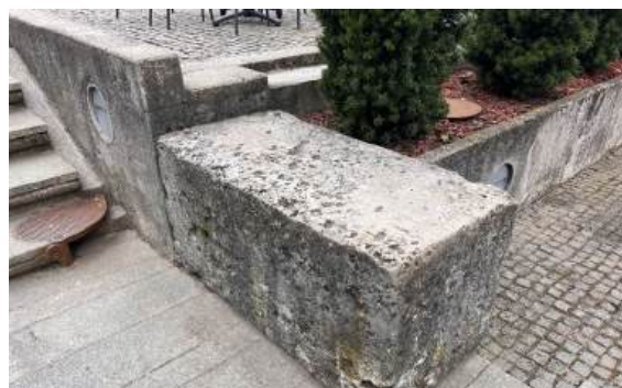
Kamniti blok se odstrani in po izvedbi hidrozaščite postavi na isto mesto
