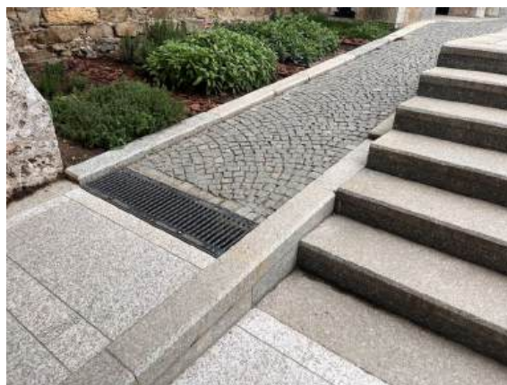
Pogled na klančino; odstranjuje se tlak iz granitnih kock do odtočne kanalete
