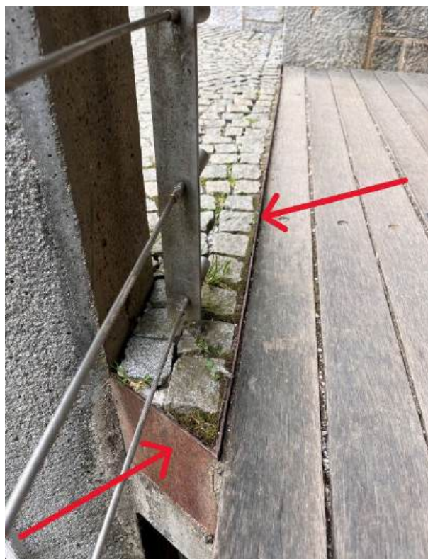
Območje C, prehod proti dvigalu - označen jeklen profil, ki ga je potrebno zamenjati z novim
