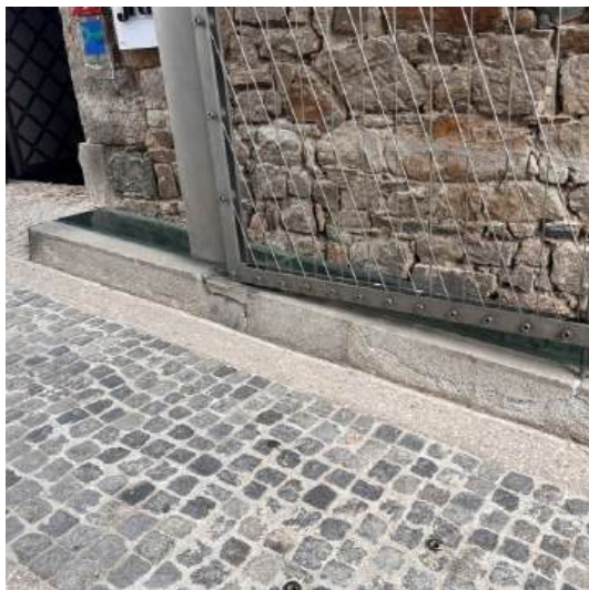
Močno razpokana betonska podlaga za vhodna vrata
