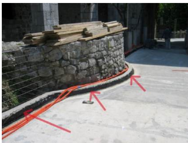
Tesnilno maso tipa Bituthene Liquid Membrane na betonu – fotografija iz sanacije leta 2006
