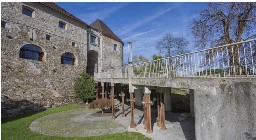
Vstopni most pred sanacijo
