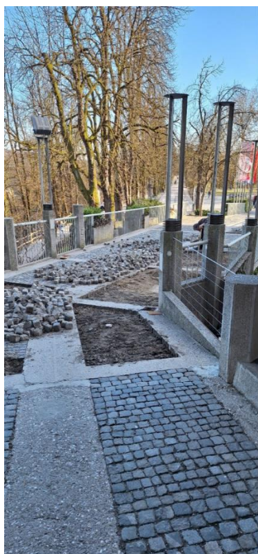
Vstopni most med sanacijo
