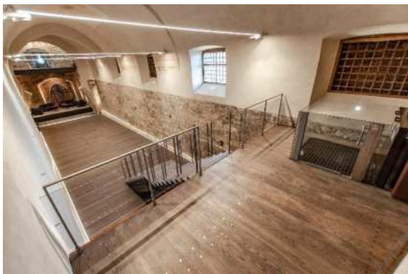
Kazemate po obnovi
